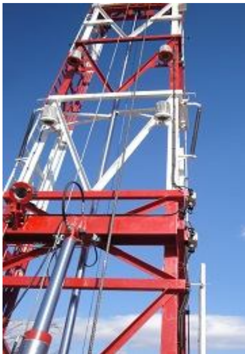
Sistemul de antiflambaj actionat la ridicarea mastului
